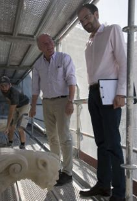
Vérification de la pose des nouvelles chimères sur la galerie des Adhémar.
